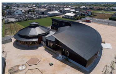
5月に竣工した新園舎
