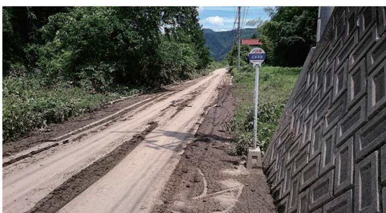
水が引き、道路に残る土砂 (江津市桜江町)
