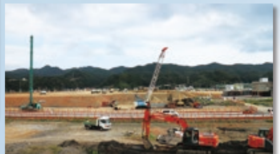
見学台に登ると、この周辺のかさ上げ 工事の様子が一望できました。
